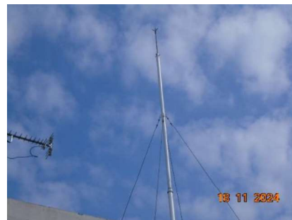
ระบบป้องกันฟ้าผ่าแบบเสาหล่อฟ้า
