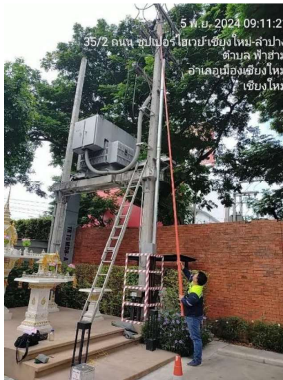
ภาพที่ 2-45 การตรวจสอบและซ่อมบำรุงหม้อแปลงไฟฟ้า
