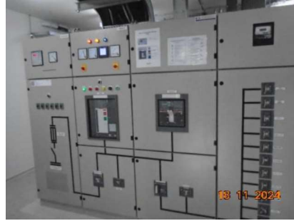
ภาพที่ 2-52 อุปกรณ์ตัดกระแสไฟฟ้าแบบอัตโนมัติ
