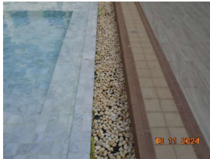
ภาพที่ 2-23 รางระบายน้ำล้นรอบสระว่ายน้ำ
